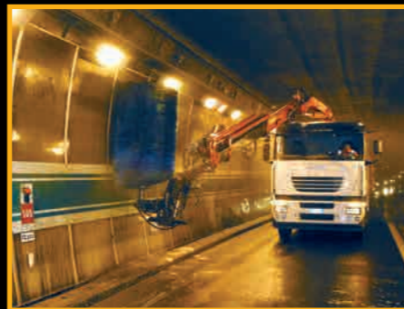
Rotolavaggio "sottolampada" con rotazione del rullo di 180°.
