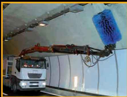
Rotolavaggio dei pedritti e delle volte verniciate con pitture "ceramizzanti".
