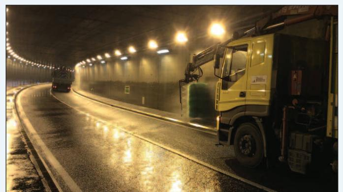
2. Exécution du lavage à la brosse des surfaces avec en évidence le nettoyage effectué par le premier camion à une hauteur de 2 à 4 m
