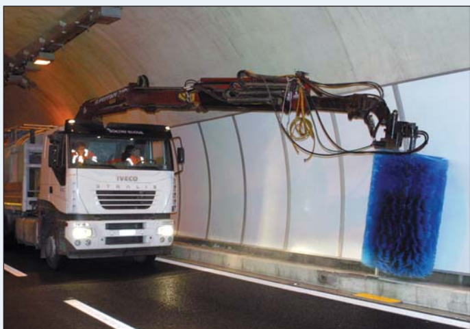
Figura 2 - Un esempio di rotolavaggio dei pannelli e il successivo risciacquo
