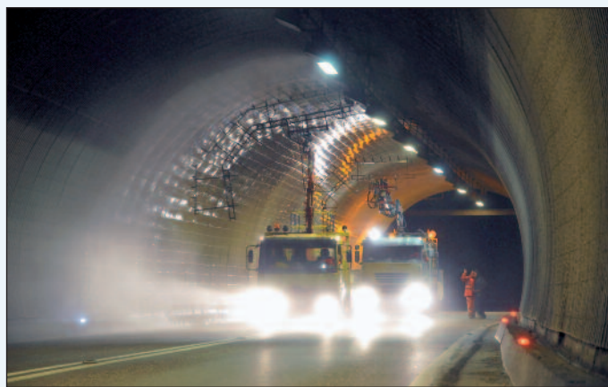
Figura 1 - La fase di lavorazione nella galleria di Brunico
