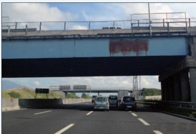
Figura 2 - Lo stato di degrado su un cavalcavia
